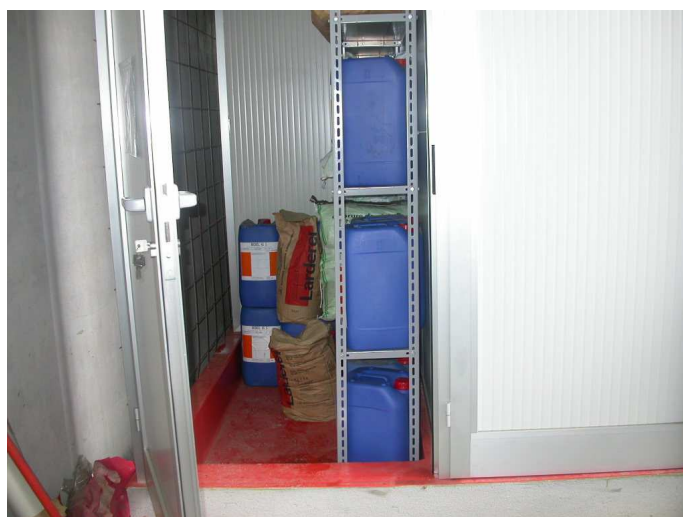
Foto n. 31: deposito materie prime con bacino di contenimento
