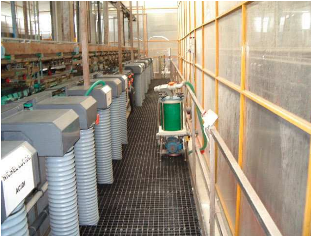
Foto 8: impianto segregato e aspirato
