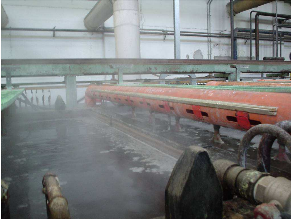
Foto 21: sistemi di aspirazione localizzata inefficaci e, probabilmente, aggiunti in un secondo momento rispetto l'installazione dell'impianto.
