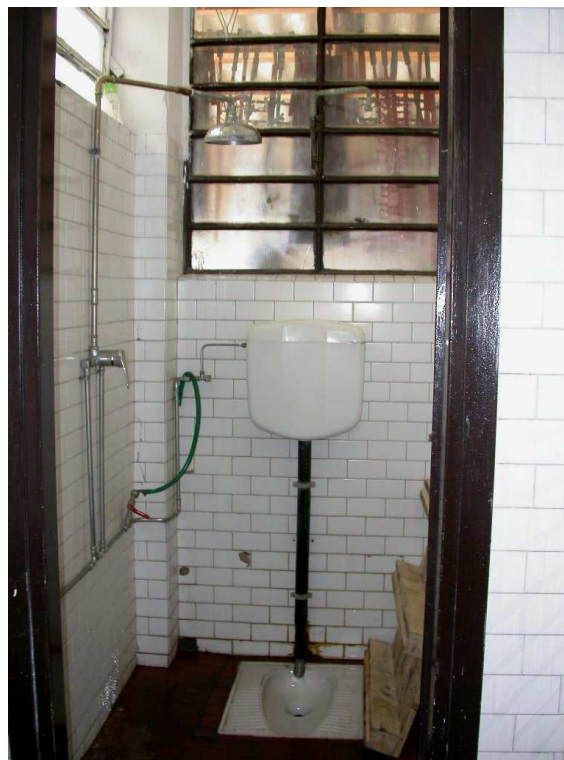
Foto n. 26: doccia di "emergenza" inadeguata
