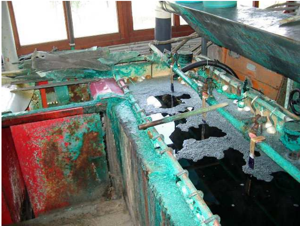
Foto 22: vasche nichelatura in condizioni di pessimo stato.
