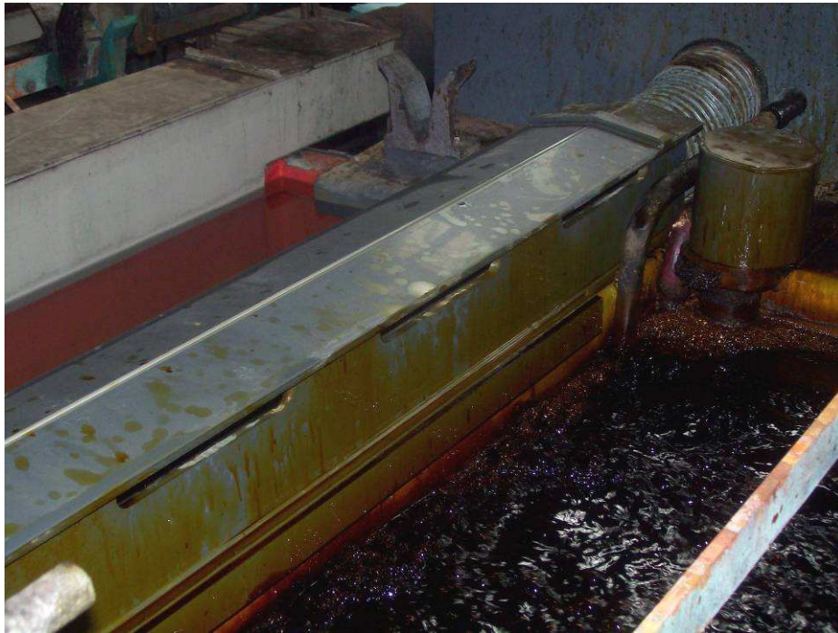
Foto 19: particolare tettoie inclinate sulle bocchette di aspirazione
