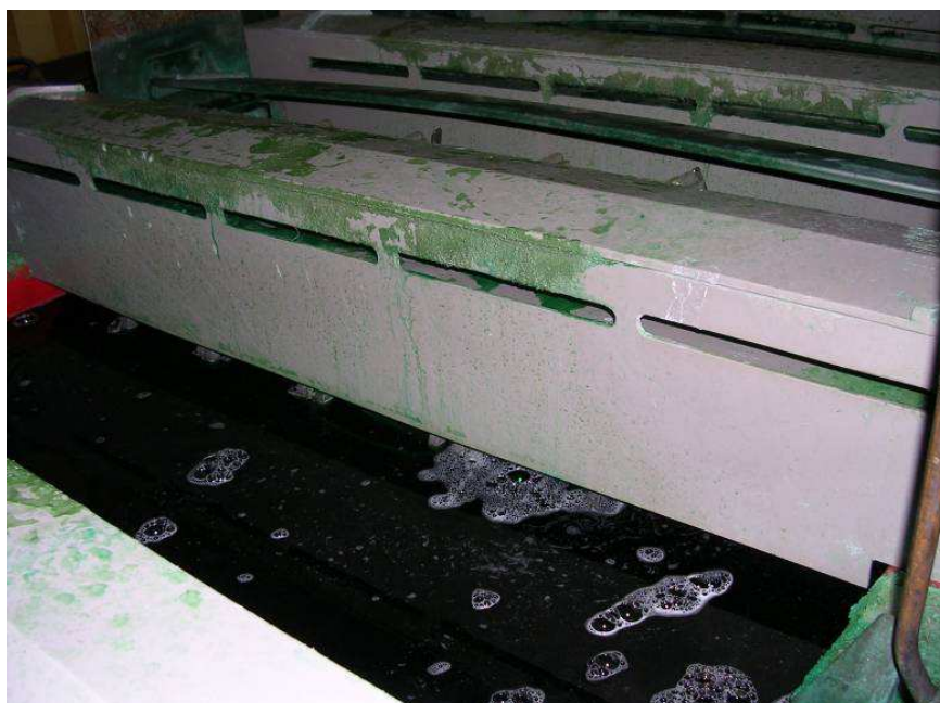
Foto 18 : Aspirazione bilaterale trasversale su impianto automatico
