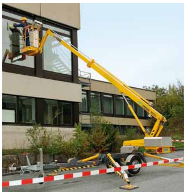
20 Pulizia di una faccia da una piattaforma aerea.
