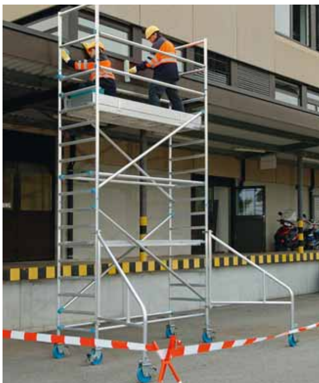
24 Pulizia di una facciata da un ponteggio su ruote.
