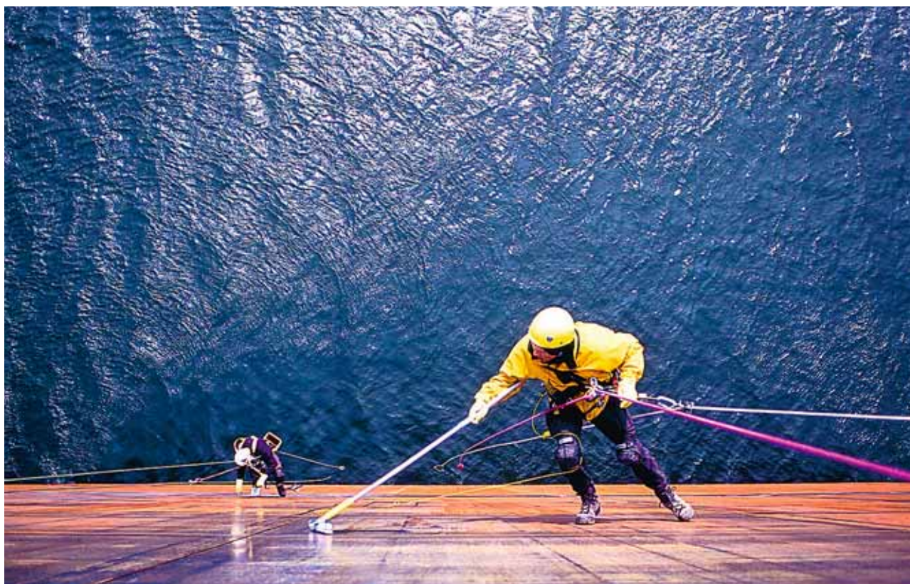
32 Lavori di pulizia in sospensione a corde portanti. L'addetto alle pulizie è assicurato a due funi fissate separatamente.
