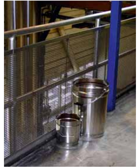
Figura 17 La griglia a maglie strette fissata sul parapetto fornisce un'efficace protezione contro la caduta di oggetti e persone.
