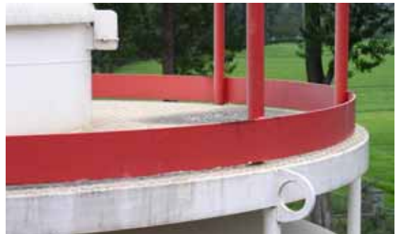
Figura 21 Lo spazio vuoto fra la superficie di calpestio e il bordo di arresto al piede permette lo scorrere dell'acqua piovana e dell'acqua di scioglimento. Esso non è superiore a 10 mm.
