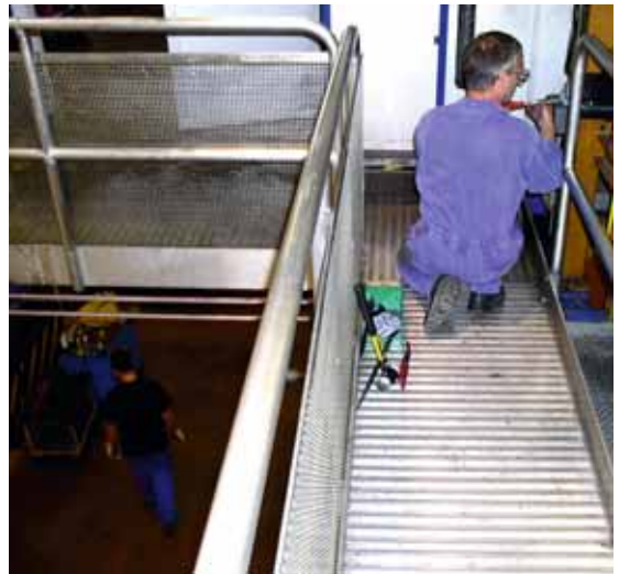
Figura 20 Parapetto su una piattaforma di lavoro con bordi di arresto al piede e griglia di riempimento a maglie strette lungo il lato rivolto verso il vuoto. Questa struttura impedisce che una persona accovacciata oppure degli oggetti possano precipitare sulla via di circolazione sottostante.
