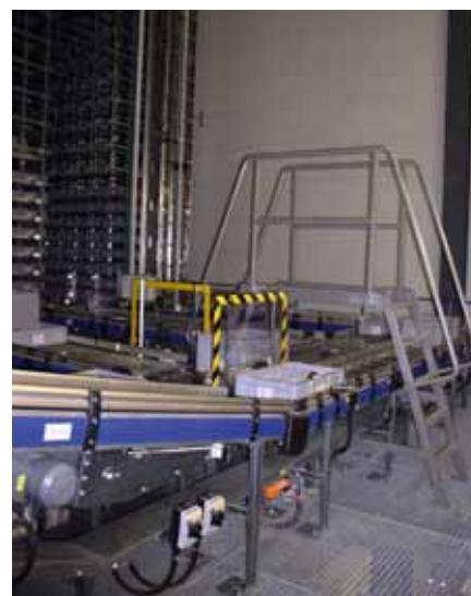
Figura 6 I parapetti su ambo i lati della passerella proteggono efficacemente persone e oggetti dalla caduta all'interno del trasportatore automatico. Anche le scale a pioli sono dotate di corrimano su ambo i lati.
