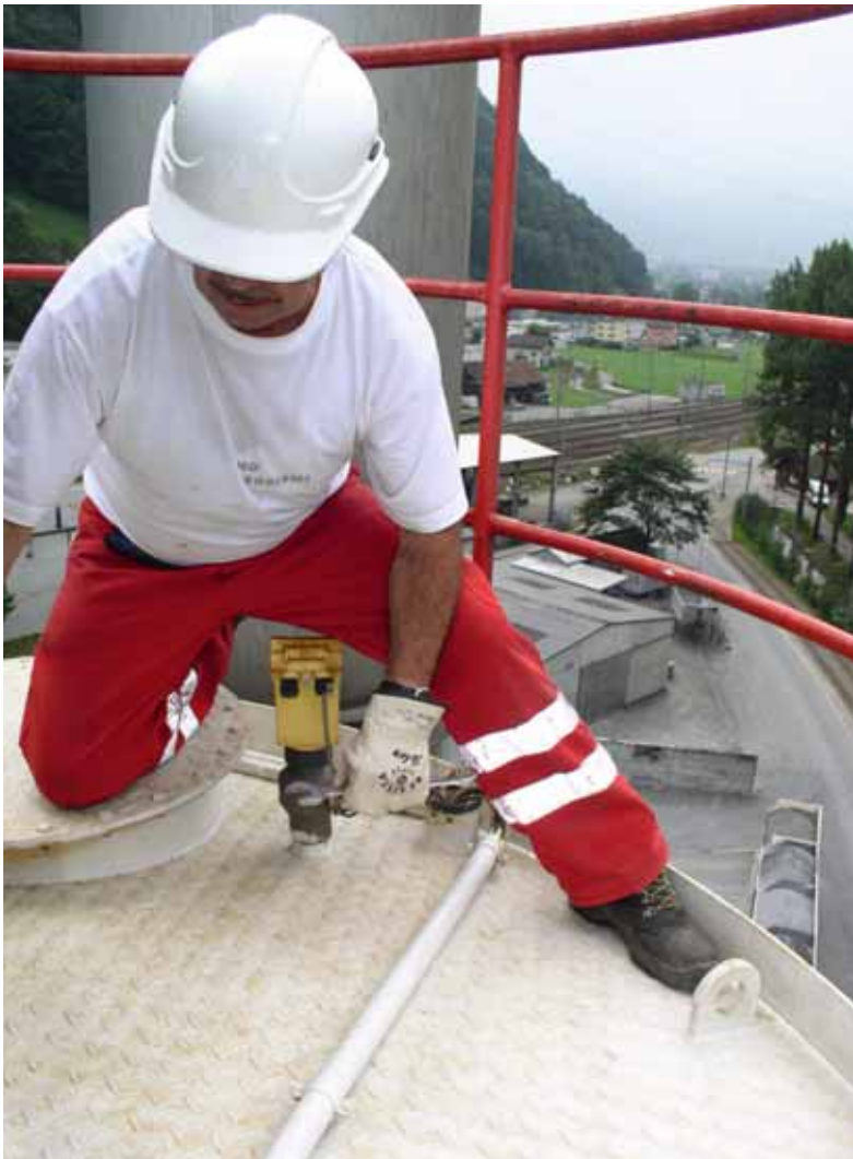
Figura 19 Il bordo di arresto al piede (altezza minima 100 mm) impedisce che gli addetti alla manutenzione possano scivolare sotto il parapetto o che degli oggetti possano cadere e ferire le persone in sosta o in transito nell'area sottostante.
