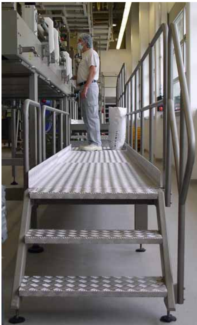
Figura 4 La piattaforma di controllo lungo l'impianto di trasformazione è protetta su ambo i lati da un parapetto. In questo caso i parapetti sono necessari perché l'altezza di caduta è superiore a 500 mm.
