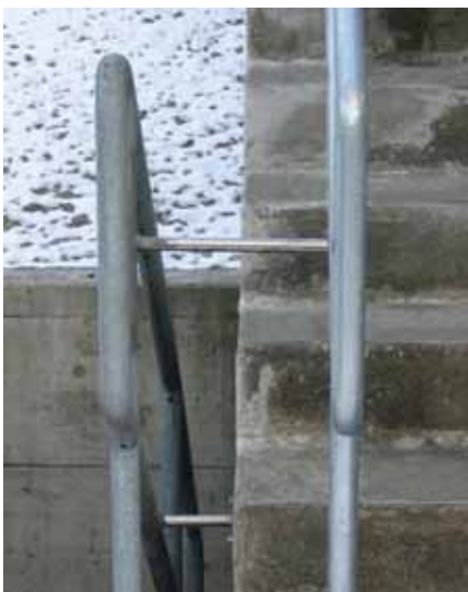
Figura 14 Parapetto su un pianerottolo con corrimano posato a distanza. Lo spazio libero tra il corrimano e la parete è come minimo di 100 mm.
