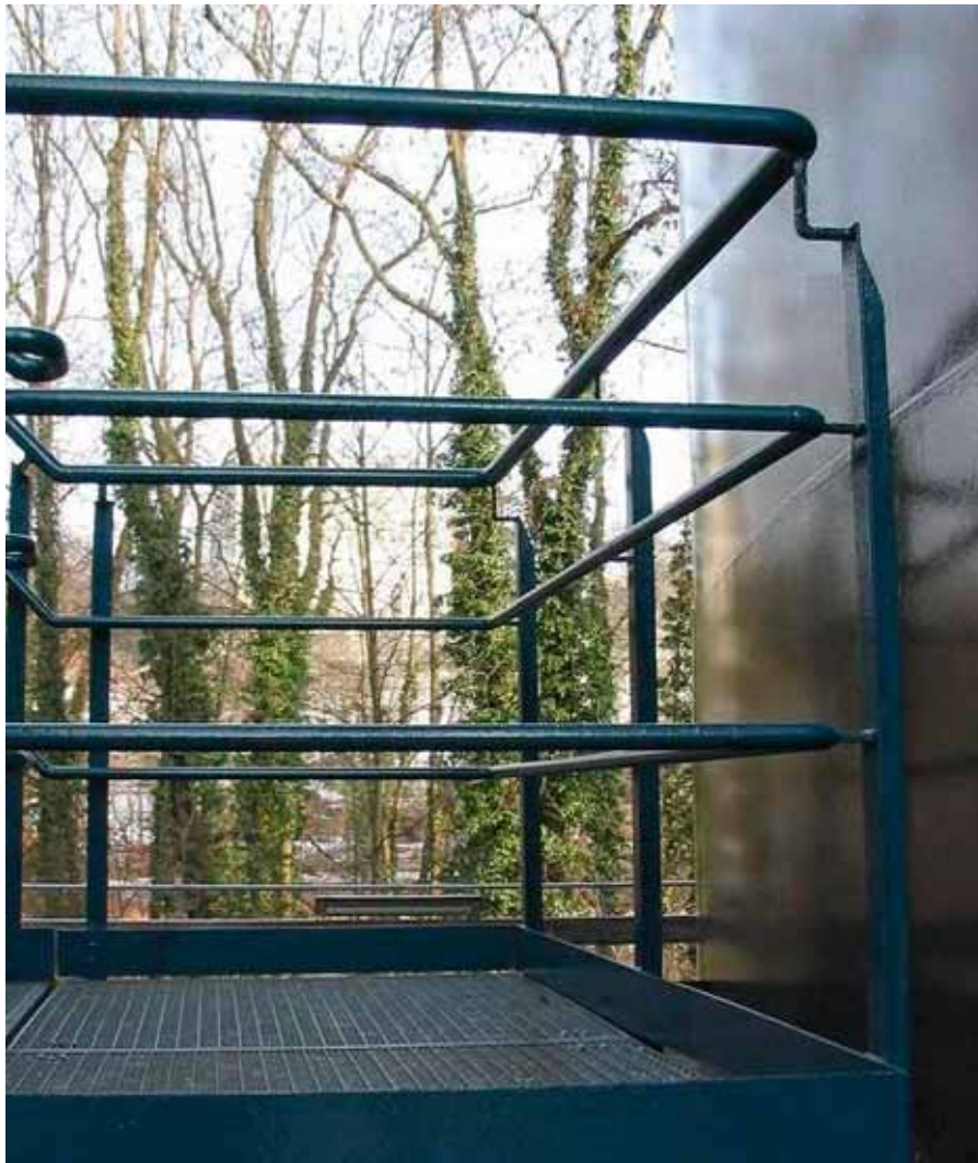
Figura 14 Parapetto su un pianerottolo con corrimano posato a distanza. Lo spazio libero tra il corrimano e la parete è come minimo di 100 mm.
