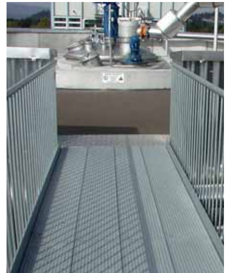
Figura 18 Parapetto con barre di riempimento verticali. La distanza fra una barra e l'altra non supera i 180 mm.
