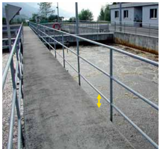
Figura 21 Lo spazio vuoto fra la superficie di calpestio e il bordo di arresto al piede permette lo scorrere dell'acqua piovana e dell'acqua di scioglimento. Esso non è superiore a 10 mm.
