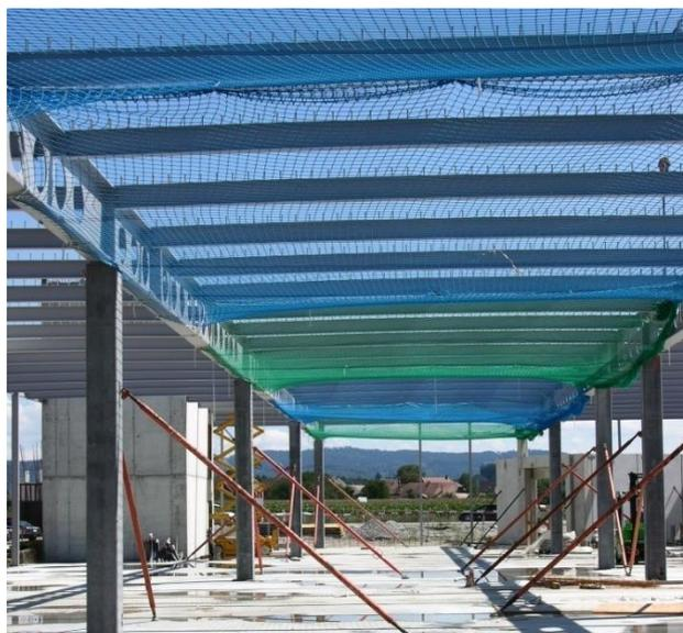
1 Le reti di sicurezza impediscono la caduta di persone all'interno della struttura in costruzione.
