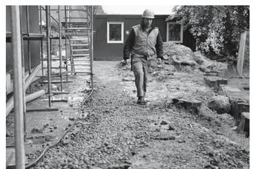
Fig. 4: l'impiego di calcestruzzo magro ha reso sicura questa via di circolazione temporanea.
