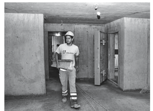
Fig. 8: anche la costruzione deve essere illuminata in modo sufficiente.
