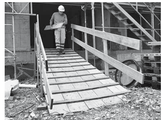
Fig. 7: accesso sicuro al cantiere grazie alle protezioni laterali e ai puntoni trasversali.
