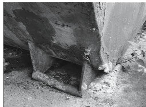
Fig. 4: gli appoggi antiribaltamento rotti devono essere sostituiti o riparati.
