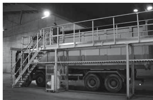
Fig. 5: piattaforma di lavoro per applicare e rimuovere le reti e i teloni.
