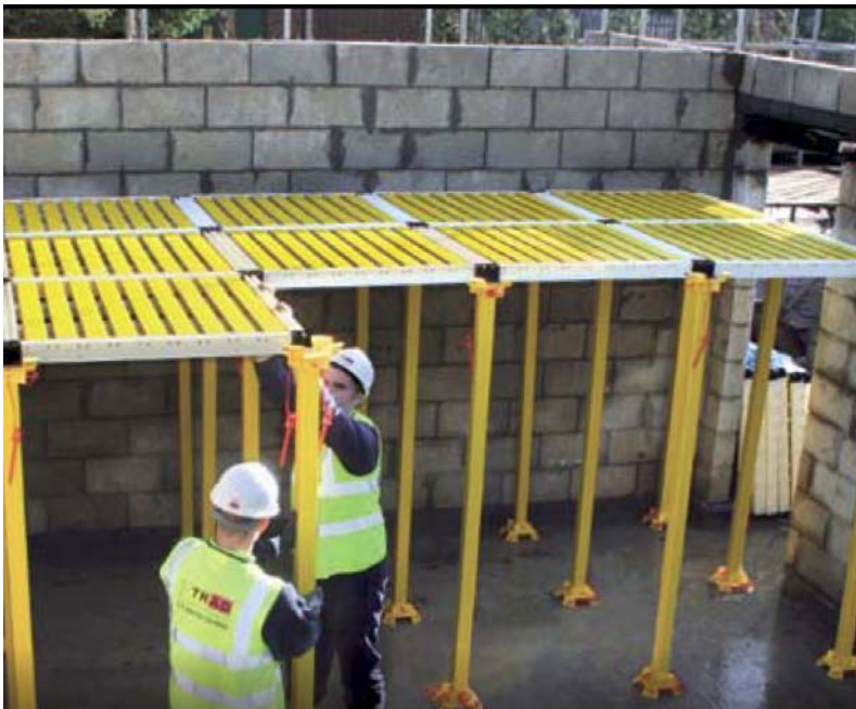
Figura 37. Operazioni di montaggio (TRAD Safety Deck)
