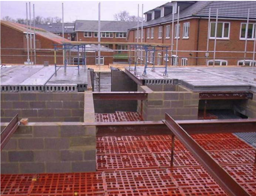
Figura 38. Impalcato di protezione.
