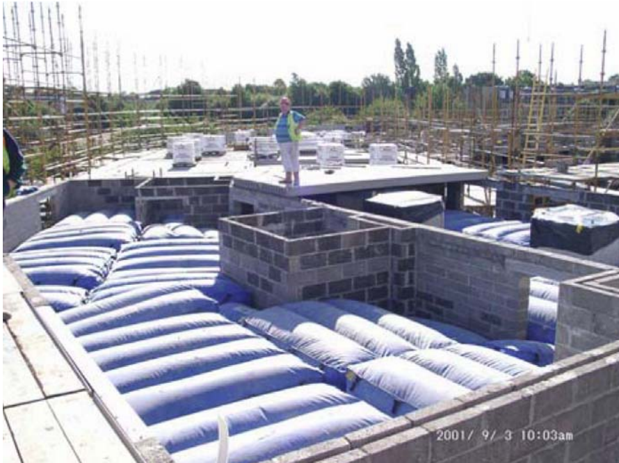
Figura 34. Impiego di materassi di protezione ( air-mat ).
