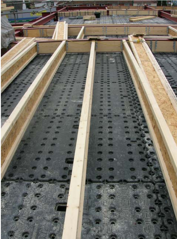
Figura 40. Sistema protettivo posto al di sotto di travature in legno.
