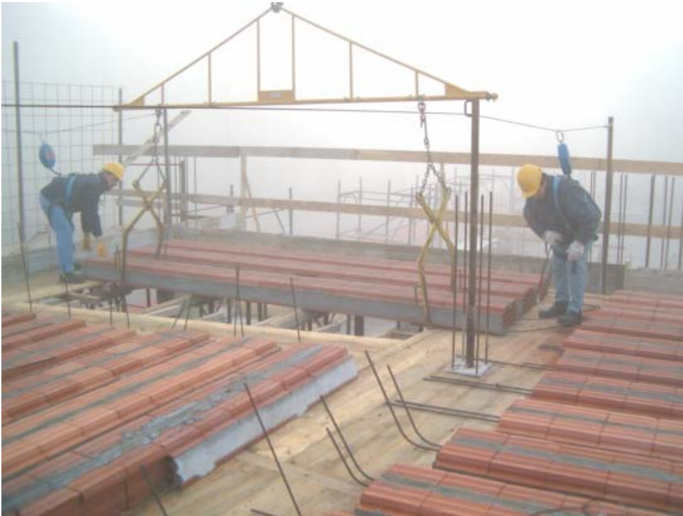
Figura 23. Posa con DPI anticaduta 56 .
