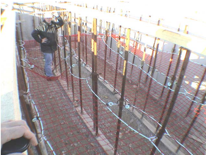
Figura 29. Rete di protezione 63 .
