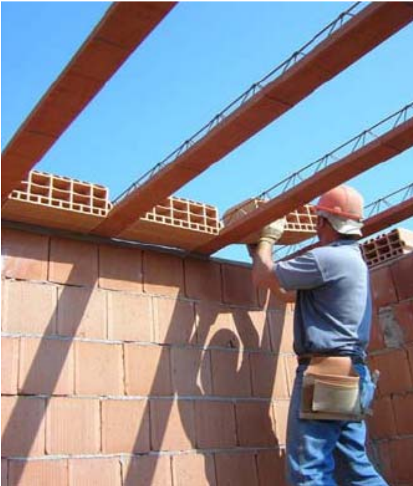
Figura 16. Posa delle pignatte utilizzando un ponte su cavalletti 44 .
