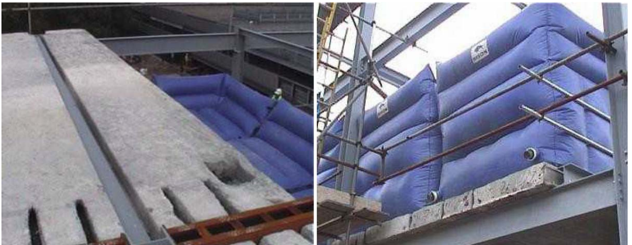
Figura 33. Impiego di materassi con funzione di protezione laterale dalla caduta dall'alto.
