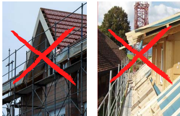
Figura 6 e 7 Evitare assolutamente pareti di protezione da copritetto inefficaci
