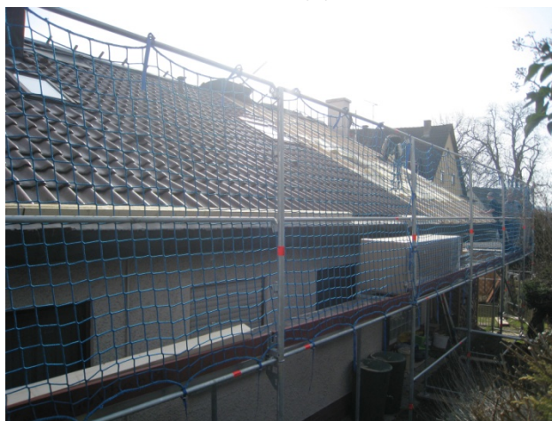
3 Parete di protezione da copritetto con rete di sicurezza a norma EN 1263, correttamente montata
