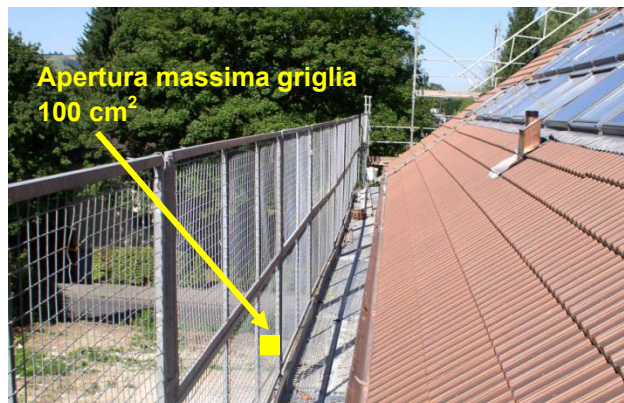
1 Requisiti della parete di protezione da copritetto
