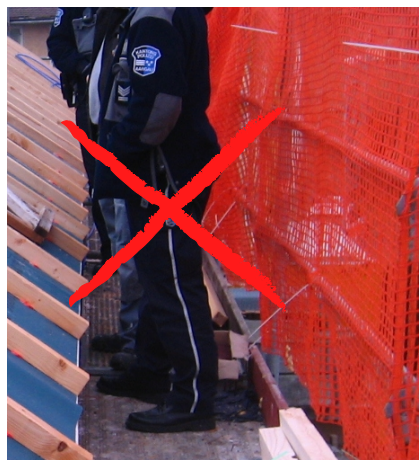
Figura 5 La polizia e le autorità inquirenti indagano sulla causa di un incidente: in questo caso una parete di protezione da copritetto difettosa, fissata in modo non corretto usando fascette fissacavi.
