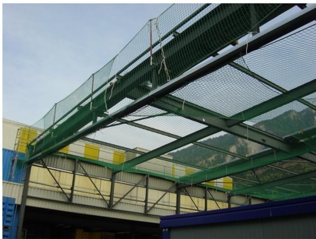
4 In questo edificio industriale la rete di sicurezza funge da protezione lungo il perimetro del tetto.
