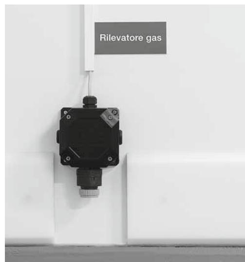
Fig. 7: impianto di rilevazione del gas
