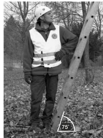
Fig. 2: per determinare la corretta inclinazione si può ricorrere alla prova del gomito. Con un angolo di inclinazione pari a circa 75° la scala può considerarsi stabile e sicura.
