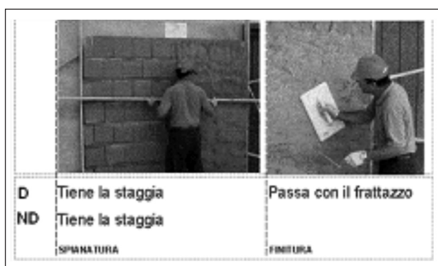
Figura 2. Azioni tecniche individuate nell'intonacatura manuale (punti 4-5-6 nel testo), suddivise per arto dominante (D) e non dominante (ND)
