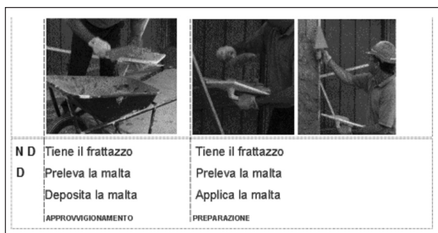
Figura 1. Azioni tecniche individuate nell'intonacatura manuale (punti 1-2-3 nel testo), suddivise per arto dominante (D) e non dominante (ND)
