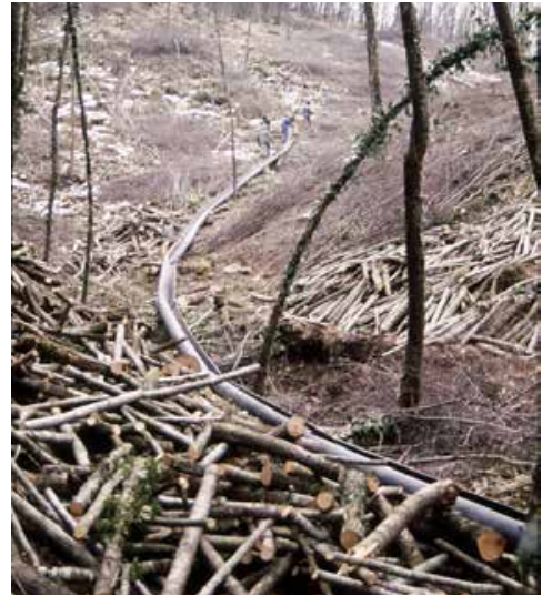
Img. 66 Avvallamento obbligato in risina di polietilene
