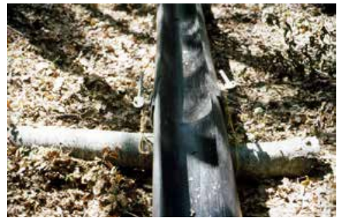
Img. 67 Agganci e ancoraggi di canalette in polietilene
