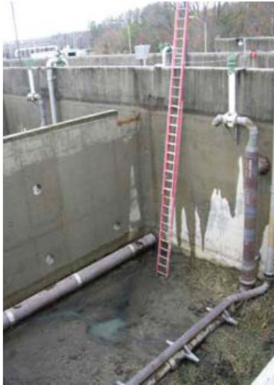
Foto 1 raffigurante un PRCS che non è chiuso. Non riuscendo a riconoscere tale ambito lavorativo come spazio confinato, i lavoratori sono esposti a rischio.
