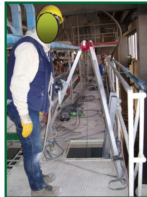
2. Il lavoratore che entra nella zona pericolosa DEVE indossare l'apparecchio portatile di misurazione in continuo della percentuale di ossigeno.
