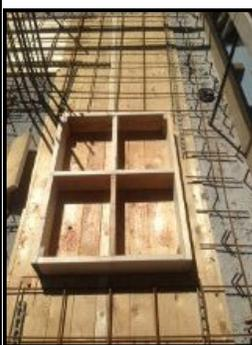
Fase 2- Predisposizione dell'armatura della soletta piena in cemento armato su cavedio con posa in opera della casseratura in legno (con traversi di irrigidimento) che nel nostro caso avrà altezza pari a 14 cm.
