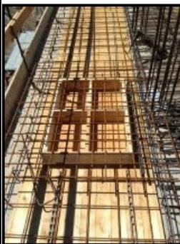
Fase 3- Posa in opera sulla casseratura della bocca da lupo precedentemente realizzata (fase n.2) di n. 2 fogli di rete metallica elettrosaldata a maglia 20x20 cm. e di diametro pari a 10 mm. fra di loro sfalsate in modo da ottenere una forometria non superiore a 10 cm.
