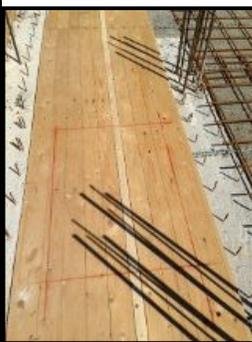
Fase 1- Tracciamento bocche da lupo sul tavolato continuo realizzato come intradosso per la successiva posa in opera della soletta piena in cemento armato che avrà in questo caso spessore pari a 20 cm..
