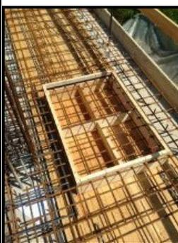
Fase 4- Posa in opera della casseratura di completamento della bocca da lupo costituita da listellatura in legno (che nel nostro caso avrà altezza pari a 4 cm.) disposta sopra la rete elettrosaldata e fissata mediante chiodatura alla sottostante casseratura precedentemente predisposta ( fase n. 2 ).
