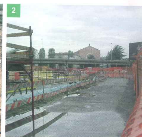
DELIMITA LO SCAVO
