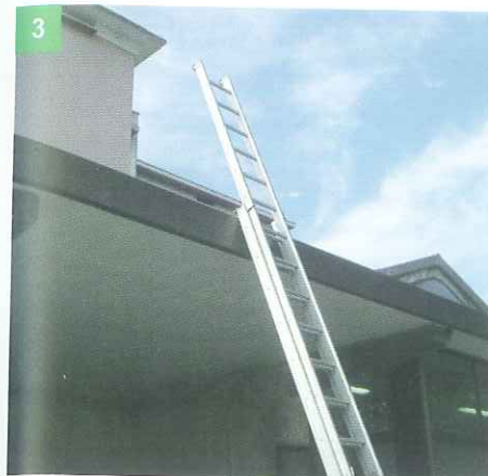
FAI SUPERARE DI UN METRO LA SCALA A MANO RISPETTO AL PIANO DI ARRIVO ED ANCORALA AD ESSO
