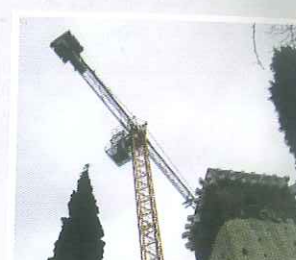
GRU A TORRE
