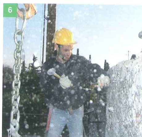
6 PARTENDO DALL'ALTO, CON MAZZETTA E SCALPELLO RIMUOVI PEZZI DI MURO E CALALI SUL PIANO DI LAVORO
