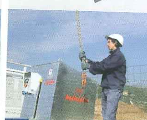
Accompagna il gancio e accertati che i materiali depositati siano stabili
