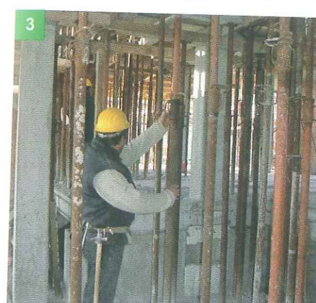
3 SMONTA GLI ELEMENTI DEL BANCHI- NAGGIO UNO ALLA VOLTA, EVITAN- DO DI FARLI CADERE DI COLPO
