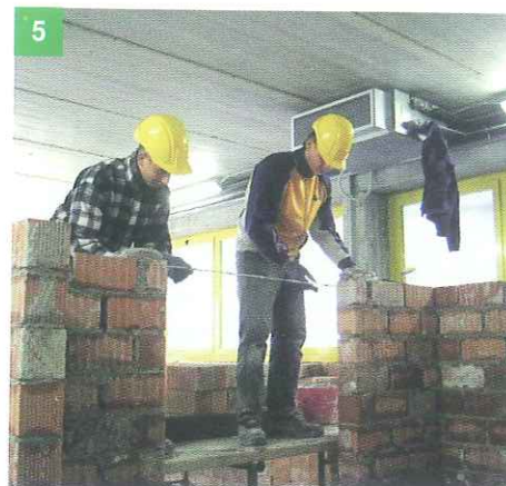
5 PONI IN OPERA LA MALTA E I MATERIALI PER LE MURATURE PERIMETRALI
