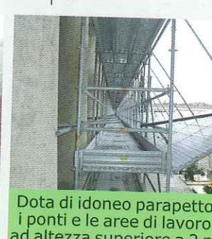
Costruisci parapetti sul perimetro del solaio e chiudi i fori
