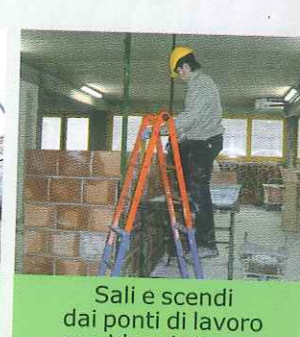
Dota di idoneo parapetto i ponti e le aree di lavoro ad altezza superiore a 2 m
