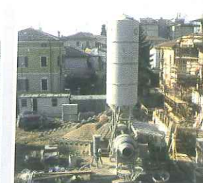
IMPIANTO DI BETONAGGIO
