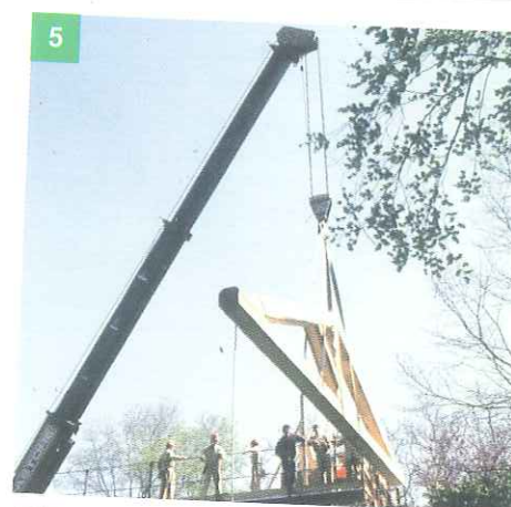
5 CARICA E SCARICA MATERIALE E ATTREZZATURE CON L'AUSILIO DI IDONEI SISTEMI DI SOLLEVAMENTO
