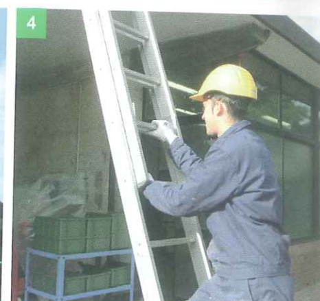
SALI SULLA SCALA CON AMBEDUE LE MANI LIBERE E SOSTIENITI CON LE MANI AI PIOLI E NON AI MONTANTI
