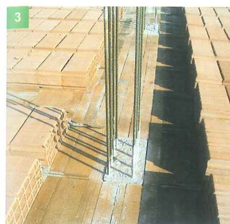
3 PULITO IL PIANO D'APPOGGIO, COLLA L'ARMATURA SECONDO I DISE- GNI E LE INDICAZIONI RICEVUTE
