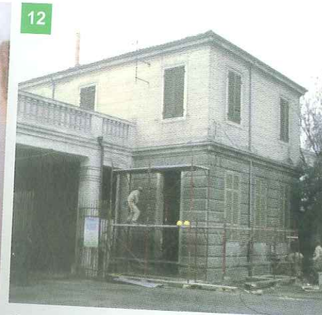
12 CALA AL SUOLO I VARI ELEMENTI E NON GETTARLI NELLO SMONTARE IL PONTEGGIO
