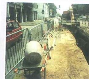
SCAVO IN TRINCEA
