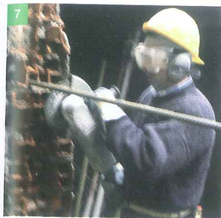
7 TAGLIA CON FIAMMA OSSIA CETILICA I FERRI D'ARMATURA
