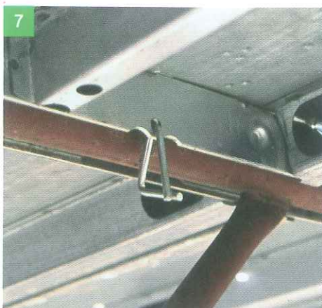
7 FORMA IL PIANO DI LAVORO CON TAVOLATI METALLICI, BLOCCANDOLI AI TRAVERSI DELLA STRUTTURA
