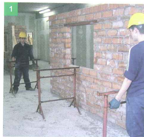
1 PONTI TRE CAVALLETTI DISTANTI M 1,80 FRA LORO, LIVELLA LE ASTE SUPERIORI E POSA QUATTRO TAVOLONI
