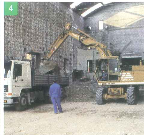
4 STAI A DEBITA DISTANZA DALLA MACCHINA CHE CARICA TERRENO SUL CAMION
