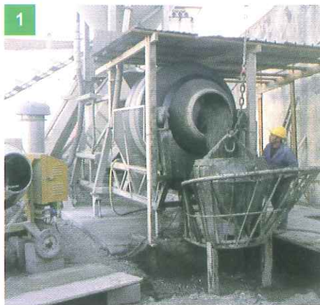
1 SISTEMA LA BETONIERA IN PIANO. SE È SOTTO LA GRU O LUOGHI DI LAVORO PROTEGGILA CON TETTOIA
