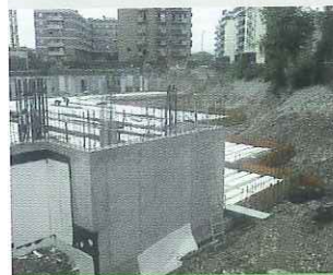
Inclina il fronte dello scavo
