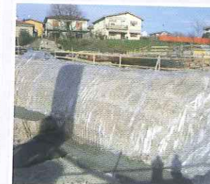
PARETE DELLO SCAVO
