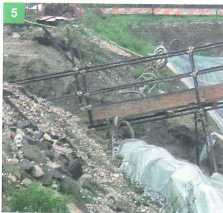
5 COSTRUENDO ANDATOIE, PASSERELLE E SCALE PREDISPONI VERSO IL VUOTO PARAPETTI REGOLAMENTARI
