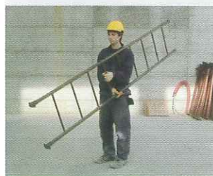
Movimenta correttamente i carichi a mano tenendoli inclinati in avanti
