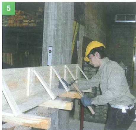
5 COSTRUISCI IL FONDO DEL CASSERO E POSIZIONA E FISSA LE SPONDE
