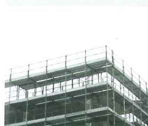
Innalza il ponteggio perimetrale sopra il ponte di lavoro interno
