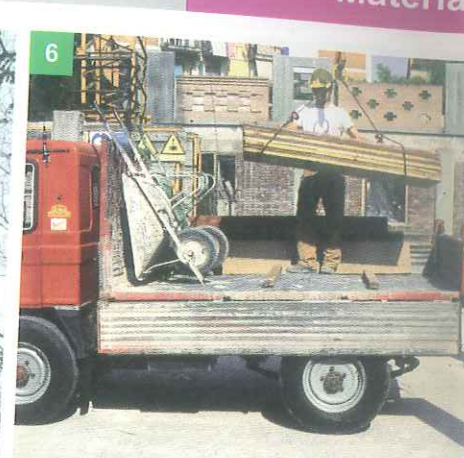
6 SCARICA A MANO IL MATERIALE E GLI ATTREZZI DI PESO INFERIORE A KG. 30
