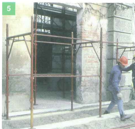
5 POSA IL PONTEGGIO SU BASI SOLIDE CON PIANI DI LAVORO ORIZZONTALI E MONTANTI VERTICALI
