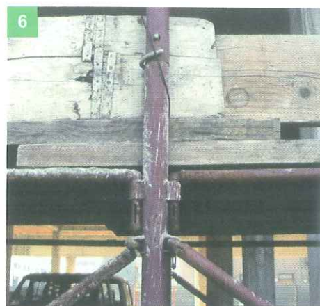
6 FORMA IL PIANO DI LAVORO CON TAVOLE DA 4 M, POSANDOLE SU 3 TELAI IN MODO CHE SORMONTINO PER 40 CM
