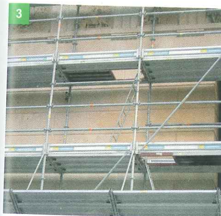
3 IL PARAPETTO REGOLAMENTARE È ALTO 1 M, CON UNA TAVOLA FERMAPIEDE DA 20 CM E UN TRAVERSO A METÀ
