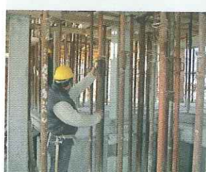
Smonta il cassero poco alla volta seguendo una sequenza logica
