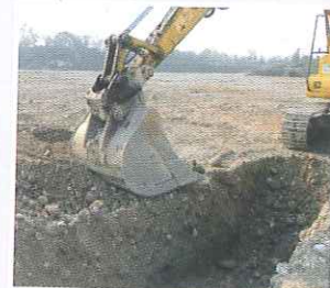
CIGLIO DELLO SCAVO
