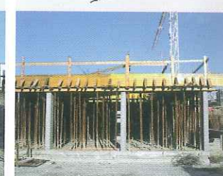
Esegui il puntellamento secondo lo schema fornito dal costruttore
