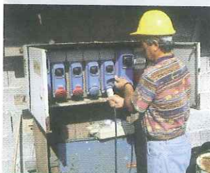
Ultimato l'impianto elettrico esegui le verifiche sui dispositivi di sicurezza
