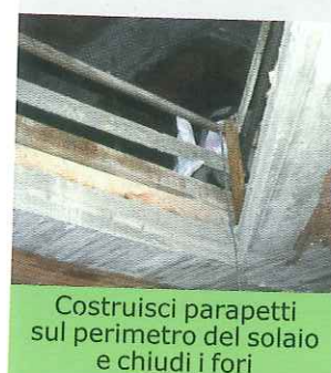
Dota di idoneo parapetto i ponti e le aree di lavoro ad altezza superiore a 2 m
