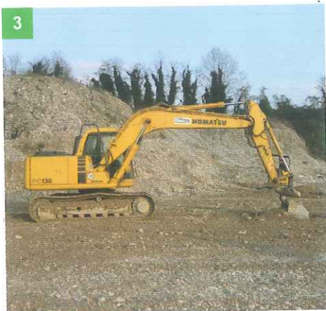
SCAVA CON LA MACCHINA
