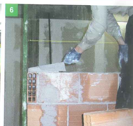
6 PONI IN OPERA LA MALTA E I MATERIALI PER LE PARTIZIONI INTERNE
