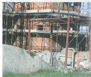
Costruisci una tettoia di protezione, non più alta di 3 m sopra la betoniera
