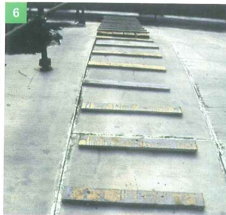
6 SUL PIANO DELLE RAMPE INCHIODA OGNI 40 CENTIMETRI LISTELLI IN LEGNO
