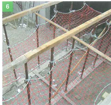
6 TRACCIA LA QUOTA D'IMPOSTA DEL SOLAIO, POSIZIONA I ROMPIRATTA E COSTRUISCI IL BANCHINAGGIO
