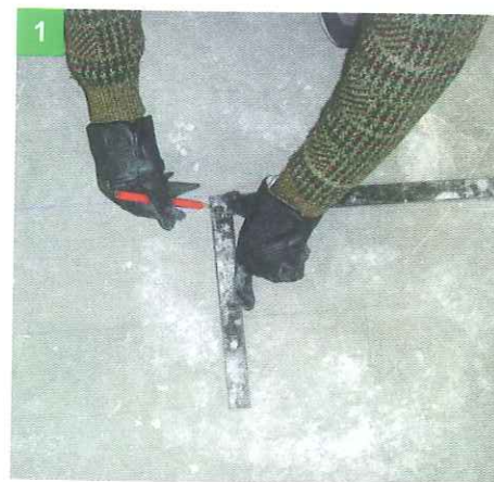
TRACCIA LA MURATURA DA ESEGUIRE
