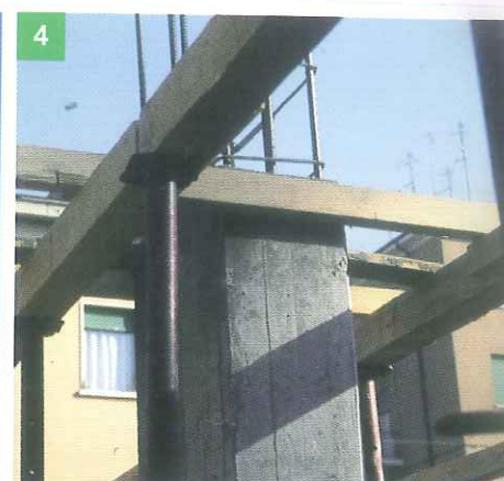
4 IMPOSTA IL LIVELLO DI TRAVI E SOLETTE, POSIZIONA LE PUNTE E COSTRUISCI IL BANCHINAGGIO
