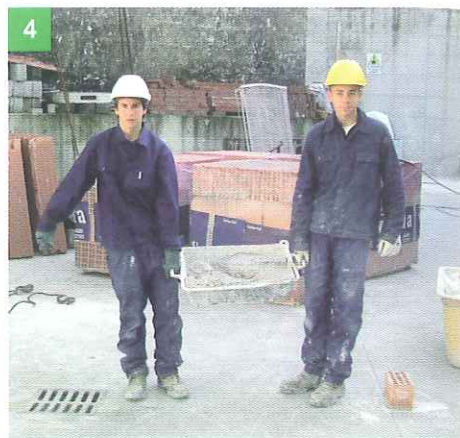
FATTI AIUTARE PER TRASPORTARE CARICHI DEL PESO SUPERIORE A 30 KG. OPPURE POCO MANEGGEVOLI
