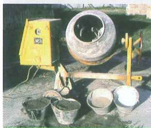
Posa la betoniera direttamente sul terreno in modo stabile e sicuro
