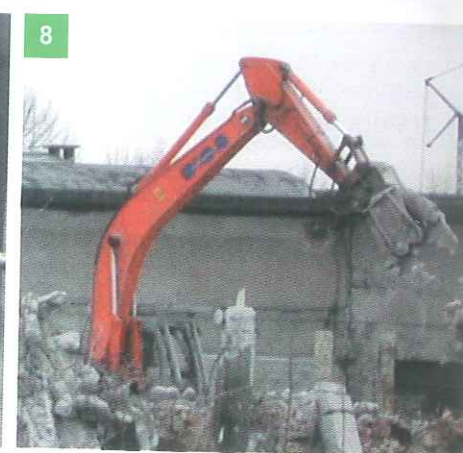
8 USA APPOSITI ATTREZZI PER DEMOLIRE ELEMENTI IN CALCE- STRUZZO DI GRANDE DIMENSIONE
