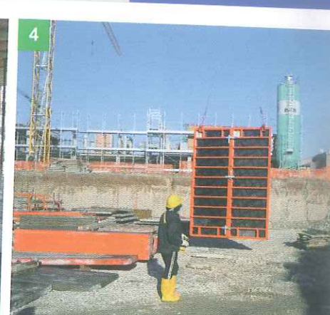
4 SMONTA I PANNELLI DI GRANDI DIMENSIONI E CONVOGLIALI NELL'AREA DI DEPOSITO
