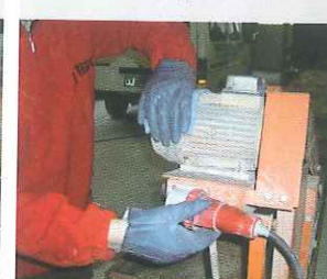
Verifica l'integrità dei cavi di alimentazione e dell'impianto elettrico
