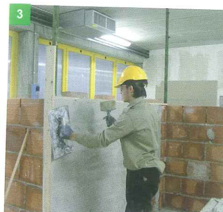
3 CON LA STAGGIA LIVELLA LA MALTA TRA LE FASCE E LISCIALA CON IL FRATTAZZO
