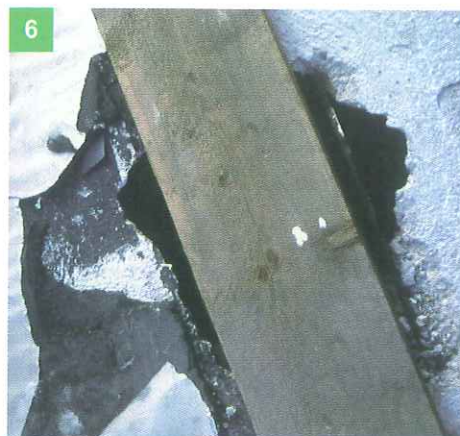
CHIUDI I PICCOLI FORI SUL SOLAIO CON TAVOLE ANCORATE CON TRA- VERSI AL DI SOTTO DEL SOLAIO
