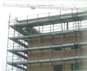
Innalza il ponteggio perimetrale sopra il ponte di lavoro interno
