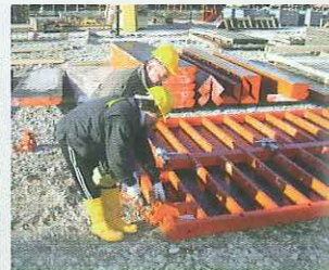
Evita di movimentare i pannelloni in presenza di forte vento
