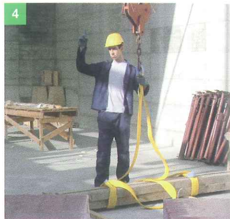
4 AGGANCIATA IL CARICO IMBRACATO E SEGNA ALL'OPERATORE CHE IL CARICO È AGGANCIATO
