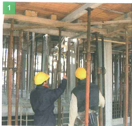
1 DISARMA QUANDO IL CALCESTRUZZO SI È CONSOLIDATO E CON L'AUTORIZZAZIONE DEL DIRETTORE DEI LAVORI
