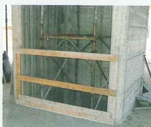
Costruisci parapetti sul perimetro del solaio e chiudi i fori
