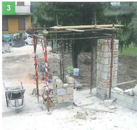
3 COSTRUISCI I SOSTEGNI PER I FILI VERTICALI E TENDI I FILI
