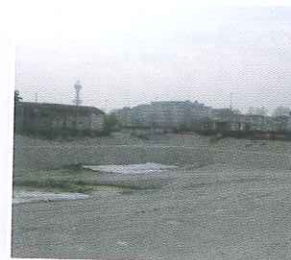
SCAVO DI SBANCAMENTO
