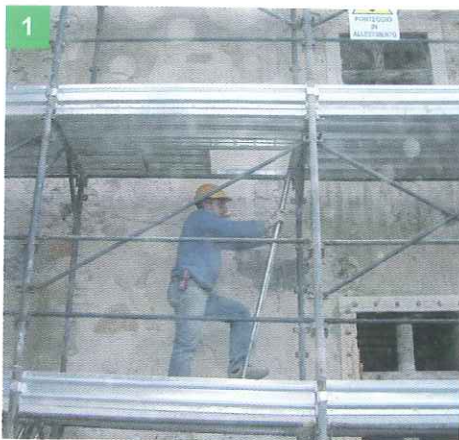
1 SALI SUL PONTE DI LAVORO USANDO LE APPOSITE SCALE
