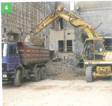
ALLONTANA IL TERRENO CARICANDOLO SUL CAMION
