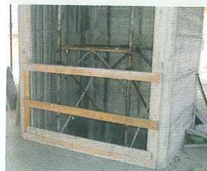
Costruisci parapetti su fori interni e sul perimetro del solaio
