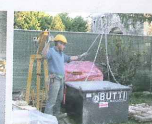
Imbraca carichi di peso idoneo alla portata dell'impianto sollevatore
