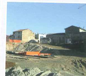
RAMPA PER SCENDERE NELLO SCAVO
