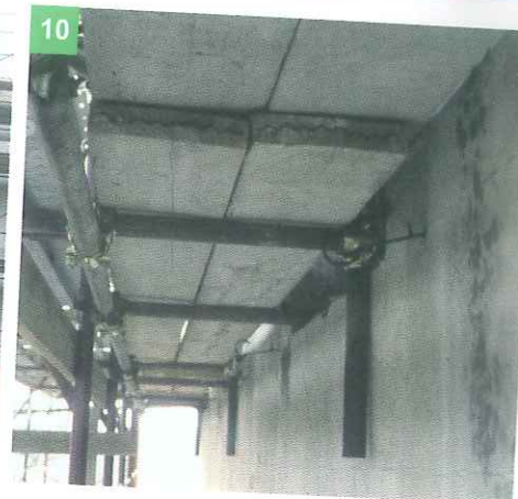
10 CHIUDI CON TAVOLONI LO SPAZIO DI RISULTA SE I MONTANTI NON SONO ADERENTI ALLA PARETE DELL'EDIFICIO
