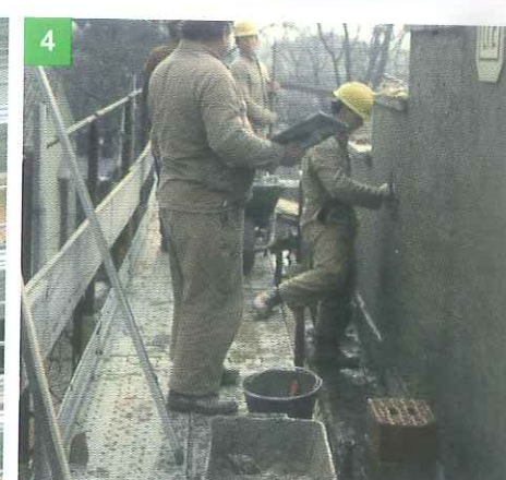
4 DEPOSITA I MATERIALI E GLI ATTREZZI SUL PONTE DI LAVORO LASCIANDO UN PASSAGGIO DI ALMENO 60 CM
