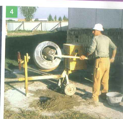
4 CARICA LA BETONIERA SENZA SBATTERE IL BADILE SULLA BOCCA
