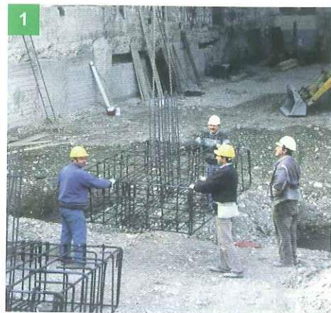
1 TRASPORTA L'ARMATURA NEL LUOGO DI IMPIEGO
