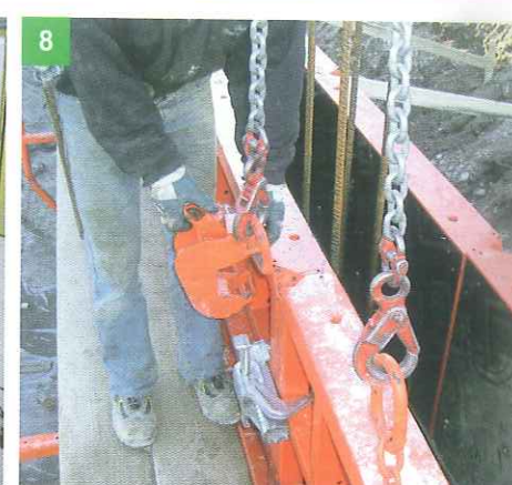
8 MONTA I PANNELLI DI GRANDE FORMATO SEGUENDO LE INDICAZIONI RICEVUTE
