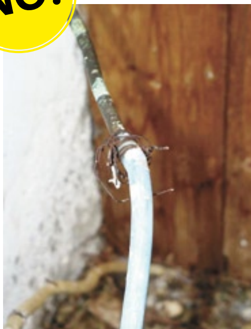
Tubi in stato di usura.
