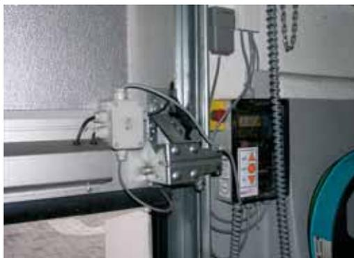
**3** Sottoporre a manutenzione il dispositivo anticaduta del portone.
