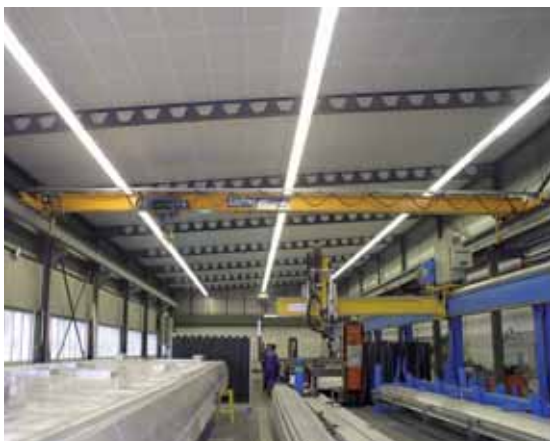
Figura 80: soffitto fonoassorbente in un locale dove si effettua la saldatura di alluminio.
