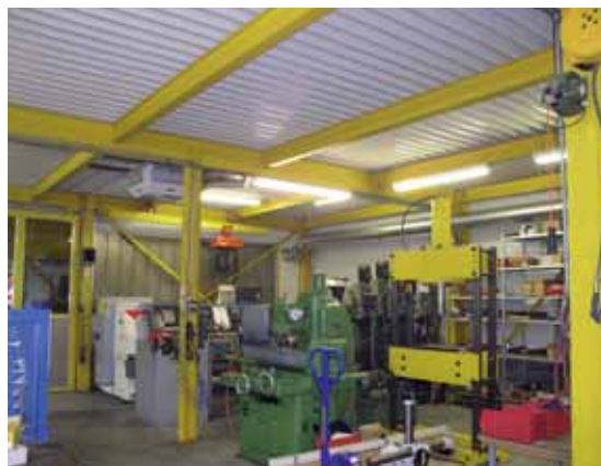
Figura 79: tipico locale di fabbricazione: costruzione in acciaio con lamiera profilata, senza un efficace soffitto fonoassorbente. Questo locale è molto riverberante e il rumore emesso dal macchinario è molto fastidioso in tutto il locale.
