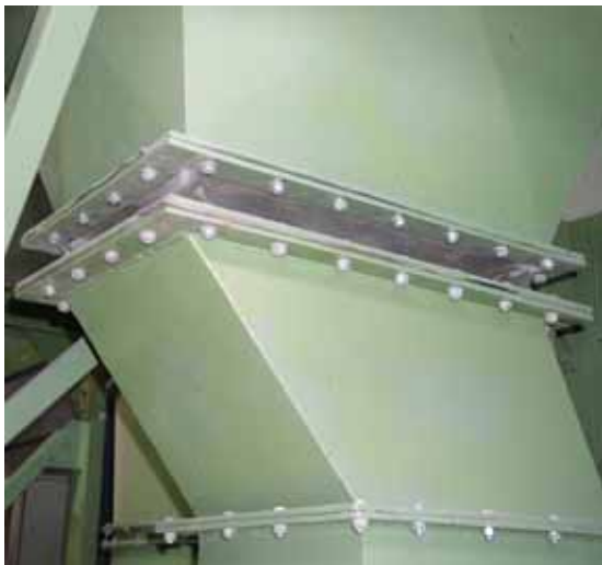
Figura 69: elemento di compensazione in plastica posizionato nella condotta di scarico dell'aria di un impianto di processo.
