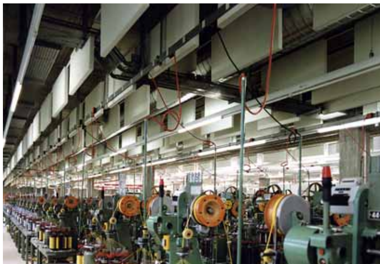
Figura 82: soffitto fonoassorbente in un'industria tessile.
