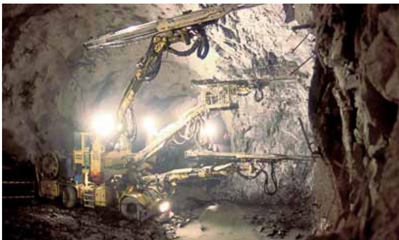
Figura 1: elevata esposizione al rumore durante i lavori all'interno di un tunnel.
