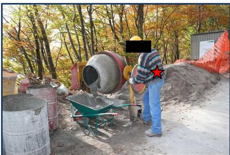
Nelle foto: la preparazione della malta. La movimentazione dei sassi da parte dell'operatore osservato segue lo stesso 'percorso' della malta: il sasso viene caricato sul secchio, passato al secondo operatore per il posizionamento sull'argano che lo porterà nelle postazioni più elevate.
