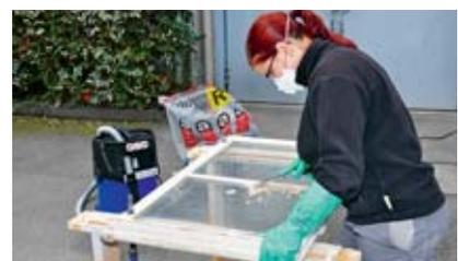
**2** Misure di protezione nella rimozione di stucco per finestre contenente amianto
