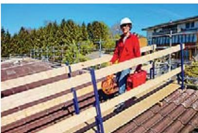
1 Tetto in lastre ondulate di fibrocemento protetto da una passerella
