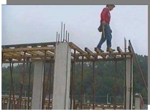
fig. 6 e 7 – realizzazione banchinaggio trave laterale e posa pignatte senza protezioni
