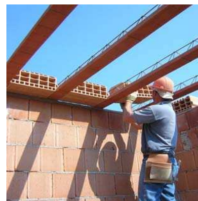
figg. 42 e 43 – Esempi operativi di posa travetti e pignatte in laterizio dalla parte sottostante del solaio
