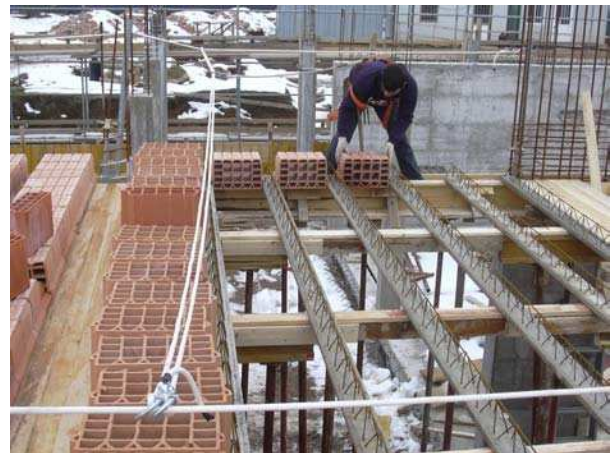
fig. 36 e 37 - Esempio di sperimentazione linea vita doppia in cantiere
