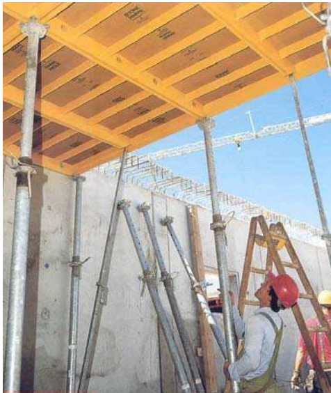
fig. 60 – 1 posa pannelli sui puntelli – 2 sollevamento pannello con asta di montaggio – 3 posa puntelli - 4 intavolato posato senza travetti intermedi - esemplificazione casseforme Hunnebeck
