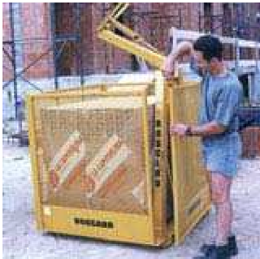
fase 3 - si chiude il cassone metallico con specifico sportello
