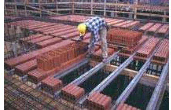
fig. 6 e 7 – realizzazione banchinaggio trave laterale e posa pignatte senza protezioni
