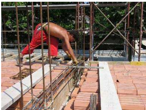
fig. 73 - Sistema di tavole di ripartizione del carico nelle operazione di legatura delle staffe
