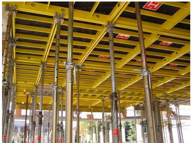
fig. 60 – 1 posa pannelli sui puntelli – 2 sollevamento pannello con asta di montaggio – 3 posa puntelli - 4 intavolato posato senza travetti intermedi - esemplificazione casseforme Hunnebeck
