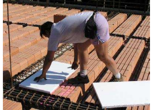
figg. 68 e 69 - predisposizione elementi per forometrie
