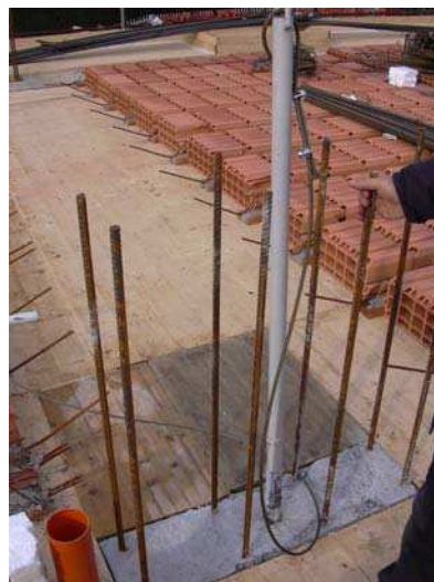
fig. 36 e 37 - Esempio di sperimentazione linea vita doppia in cantiere
