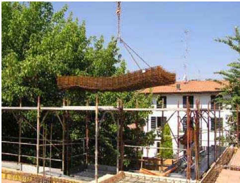
fig. 72 - sollevamento reti elettrosaldate – posa travetti nella zona di appoggio
