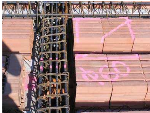
figg. 68 e 69 - predisposizione elementi per forometrie
