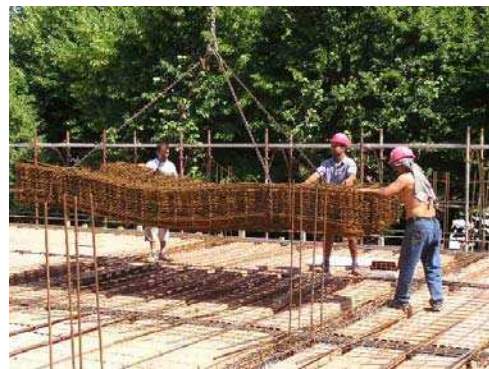
fig. 72 - sollevamento reti elettrosaldate – posa travetti nella zona di appoggio
