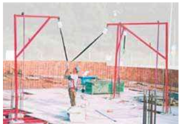
fig. 62 – Esempificazione sistema Alsina per posa dall'alto intavolato continuo
