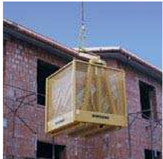
fase 4 – si può sollevare il carico in quota
