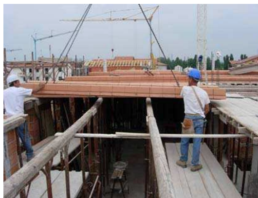
figg. 42 e 43 – Esempi operativi di posa travetti e pignatte in laterizio dalla parte sottostante del solaio
