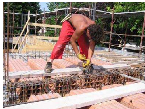
fig. 73 - Sistema di tavole di ripartizione del carico nelle operazione di legatura delle staffe
