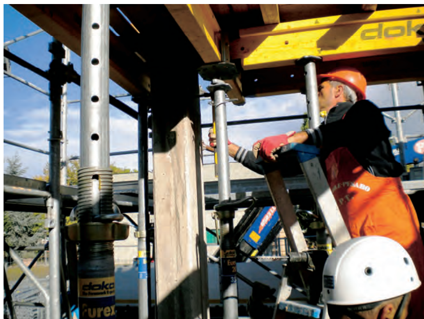
Figura 23– Fase della realizzazione dei punti di ancoraggio della rete ai pilastri
