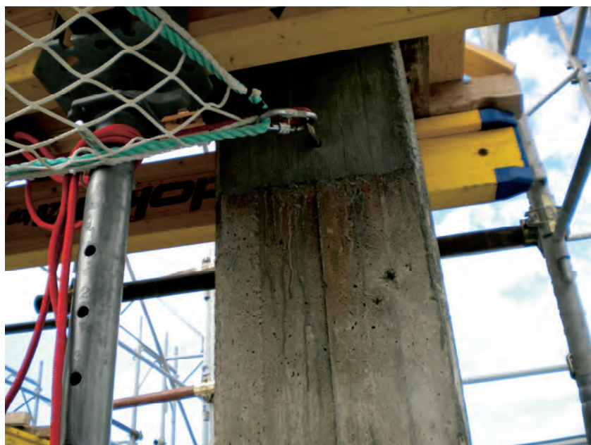
Figura 25 – Dettaglio dell'ancoraggio d'angolo della rete al pilastro
