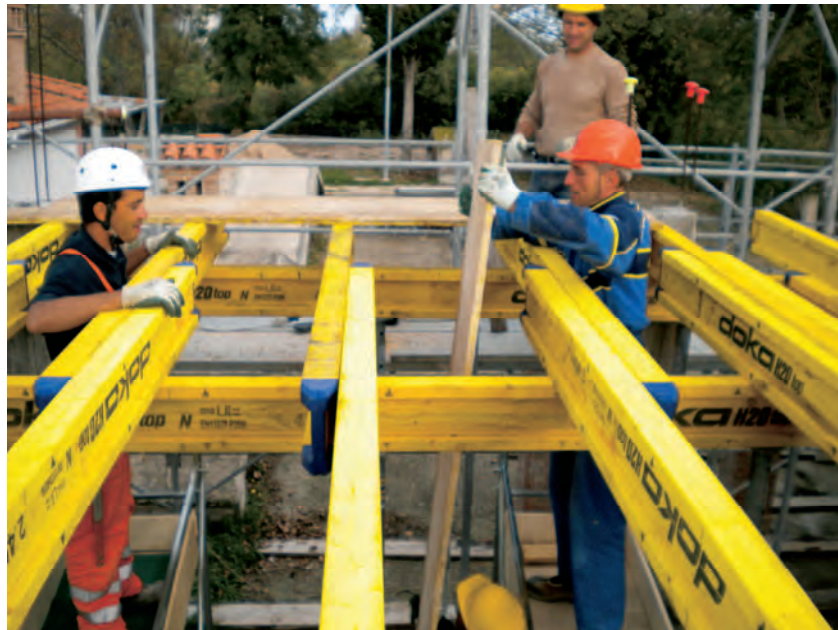
Figura 48 – Fase di montaggio del tavolato
