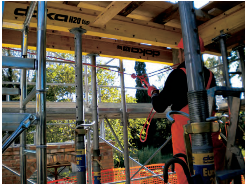
Figura 24 – Montaggio della fune di bordo ai pilastri
