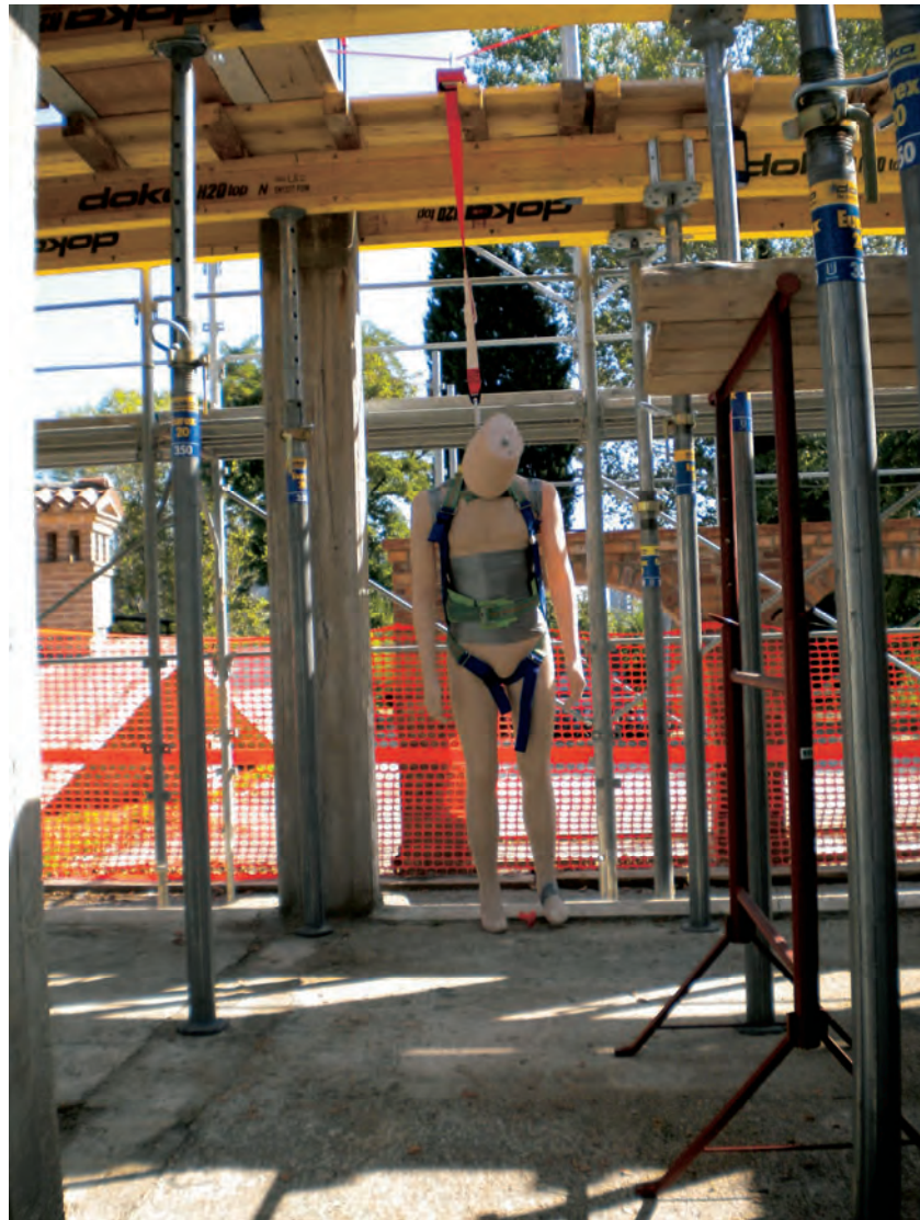
Figura 35 – Manichino appeso al sistema anticaduta dopo la caduta
