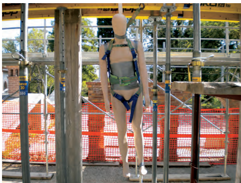
Figura 39 – Manichino appeso al sistema anticaduta dopo la caduta nella ripetizione della prova dal bordo con ancoraggio della fune alla sommità del pilastro
