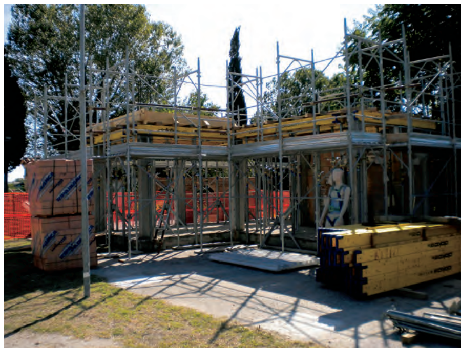
Figura 5 - Foto del cantiere di sperimentazione
