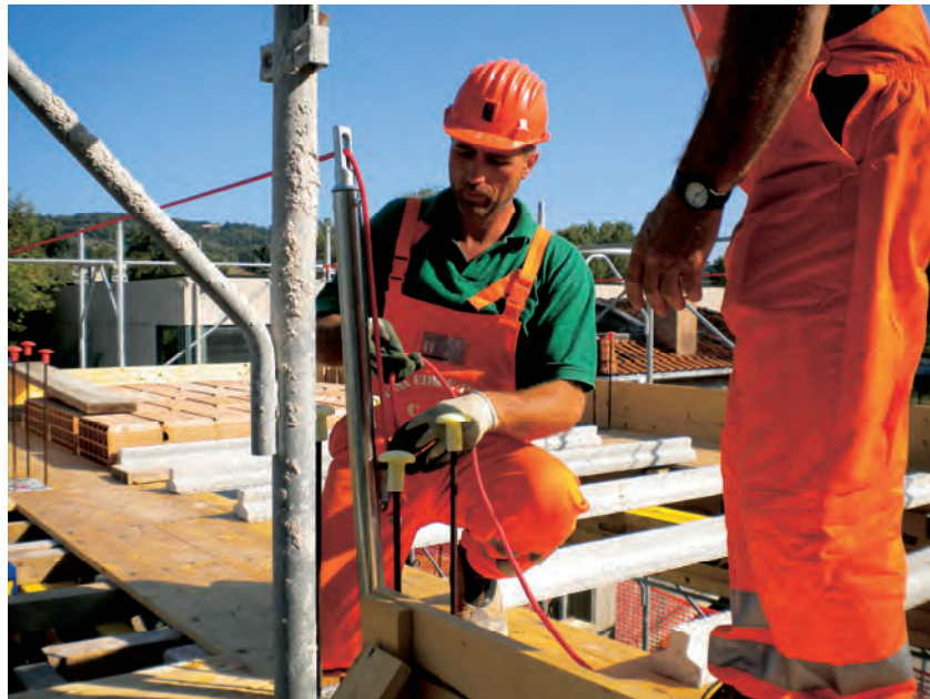
Figura 33 – Fase di ancoraggio della fune tessile
