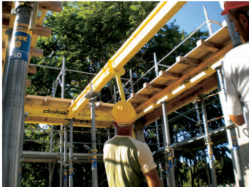
Figura 46 - Fase di montaggio dell'orditura primaria dal basso con l'uso di apposite forche
