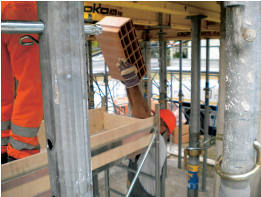
Figura 18 – Fase del passaggio delle pignatte dal basso
