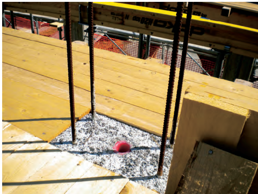
Figura 31 – Boccola in plastica inserite sulla sommità del pilastro
