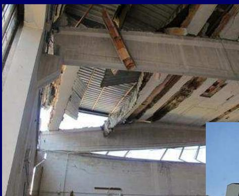
Collegamenti trave-pilastro e elementi di copertura-trave assenti, collegamenti tra pannelli di tamponamento e pilastri inefficaci, ...
