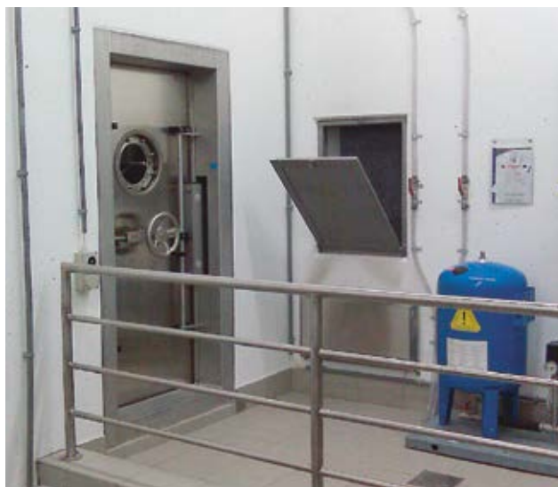
Fig. 6 e 7 i locali con elevata concentrazione di radon vengono chiusi ermeticamente.
