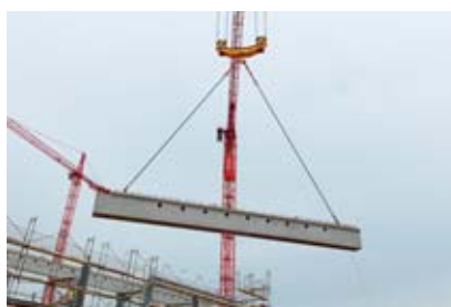
2 Imbracare correttamente i carichi asimmetrici.
