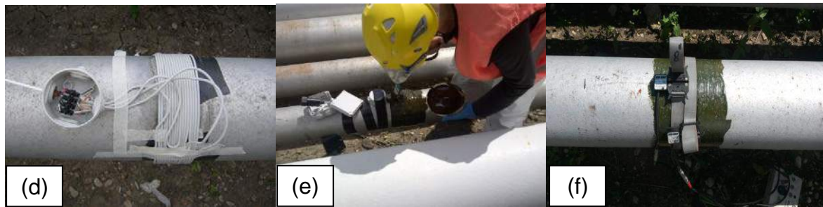
Fig. 9 – Installazione dei sensori magnetostrittivi
