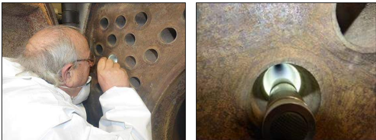
Fig. 4 - Controllo visivo del fascio tubiero
