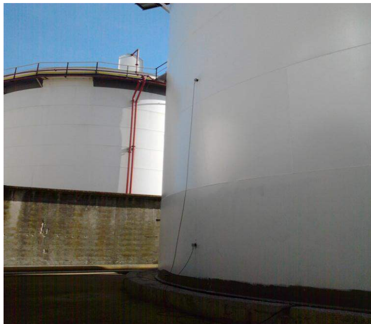
Figura 2– Posizionamento dei sensori
