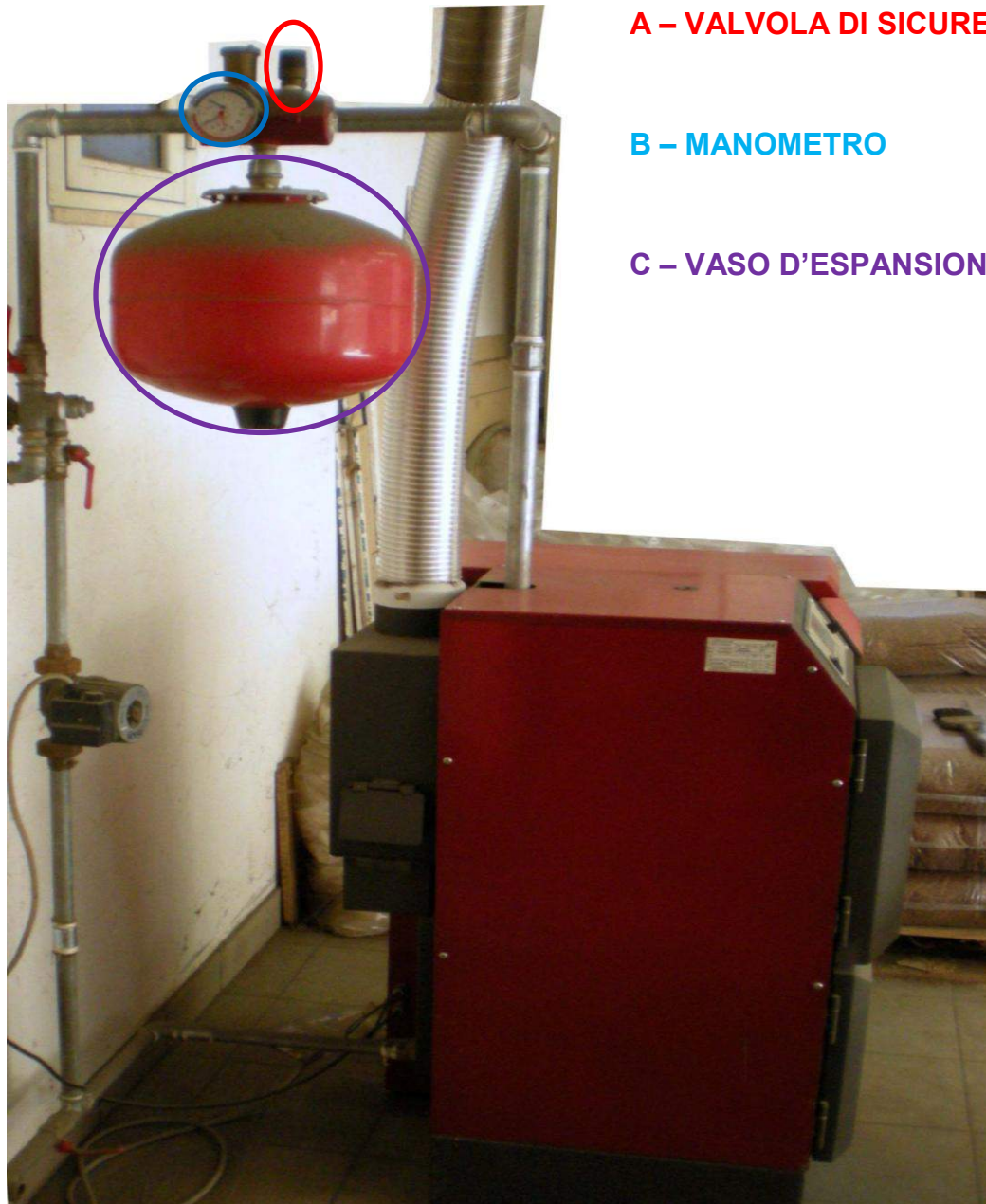
Figura 5 – Caldaia per acqua calda accessoriata con.
