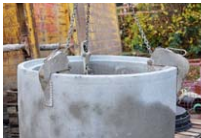
2 Accessori di sollevamento utilizzati correttamente per lo spostamento di elementi di un pozzetto
