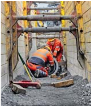
Regola 8 Messa in sicurezza degli scavi.
