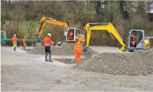
1 Formazione per la manovra di macchine edili
