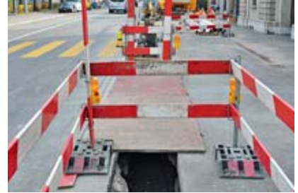
3 Passerella su uno scavo
