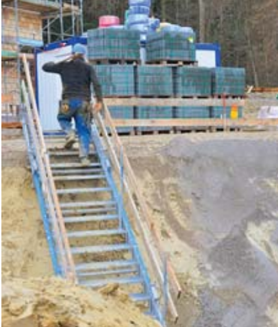
1 Accesso allo scavo tramite scala a gradini
