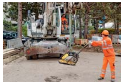
3 Movimentazione corretta di un carico con il bagger gommato
