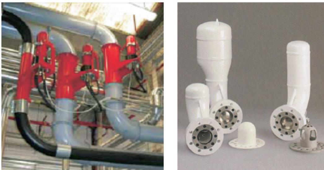
Figura 6: Sistemi di soppressione installati lungo le tubazioni del sistema
