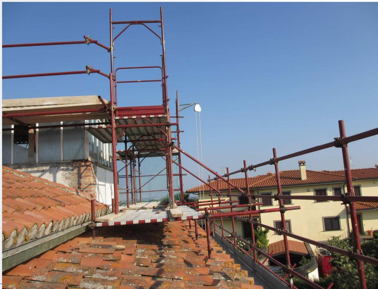
N.B. Il puntellamento della copertura in legno può essere realizzato anche con puntelli prefabbricati a croce che presentino caratteristiche tecniche (vedi libretto puntello) tali da resistere ai carichi esercitati dal ponteggio sul solaio da puntellare.
