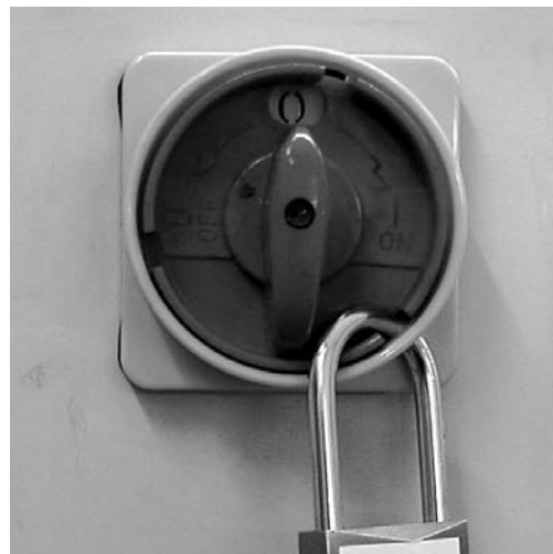
Fig. 1: interruttore di sicurezza lucchettabile
