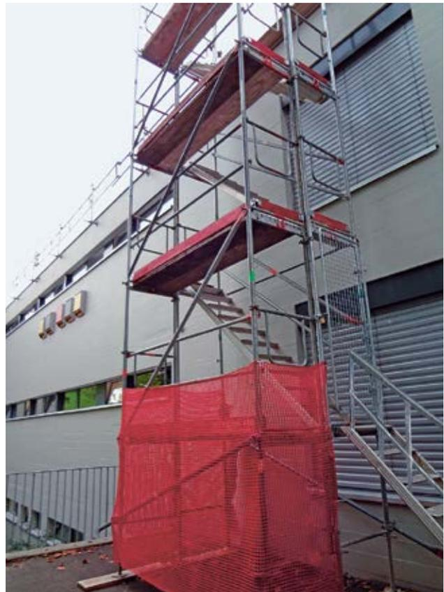
**Fig. 3** Accesso sicuro tramite un corpo scala (ponteggio)
