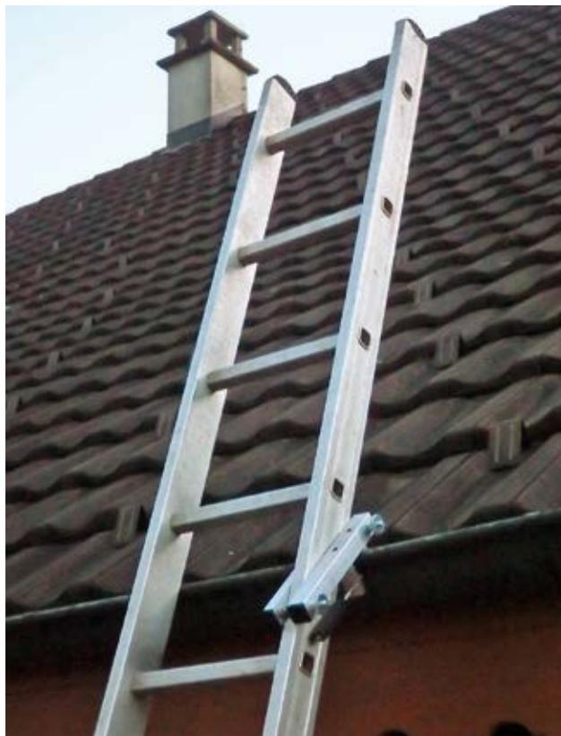
Fig. 19 Accesso sicuro al tetto per lavori di breve durata > scala a pioli bloccata al bordo tetto
