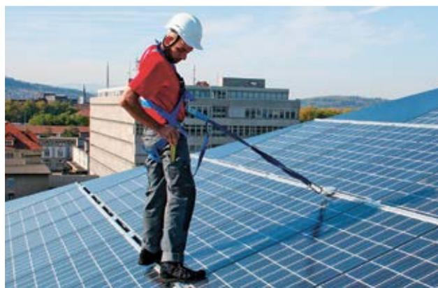
Fig. 12 Dispositivo di ancoraggio integrato nell'impianto solare
