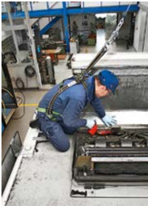
3 Messa in sicurezza con DPI anticaduta
