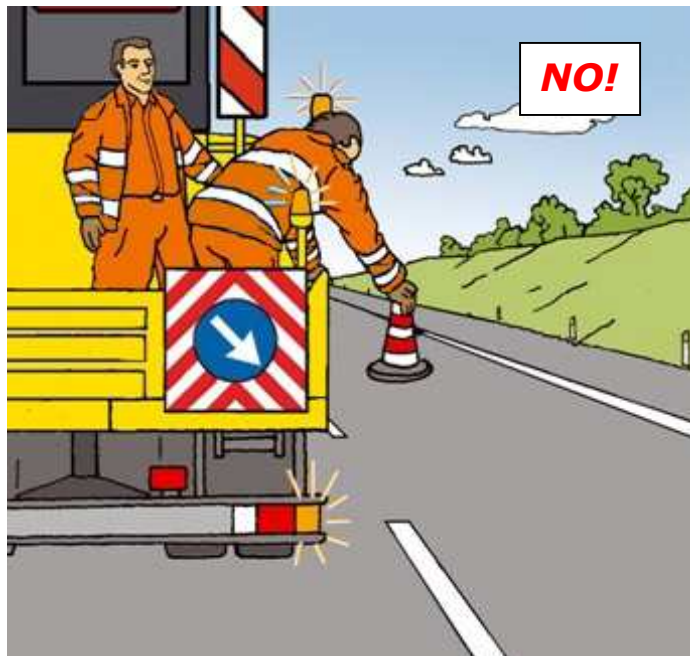
Figura 36 – Posizionamento dei con i o delineatori flessibili: comportamento scorretto
